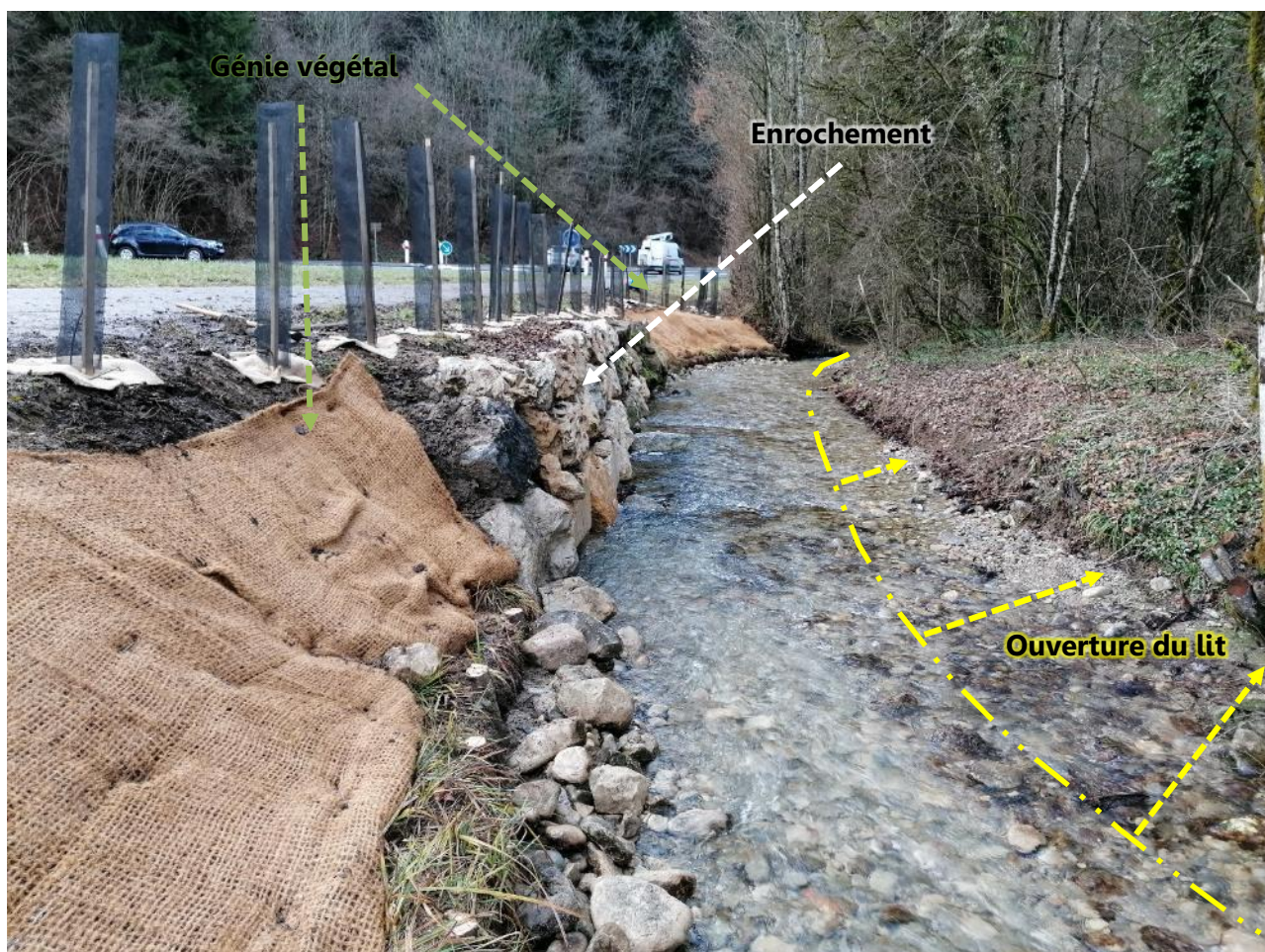
Figure 6: Exemple d'aménagement (sans risberme) avec ouverture en rive droite et protection diversifiée en rive gauche
